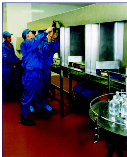
Установка просмотровых кабин
