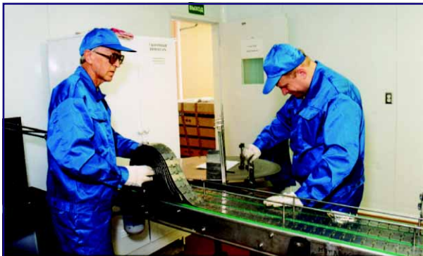
Сборка конвейерной линии
