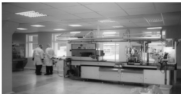
На фото: монтаж блистерной машины фирмы САМ (Италия)
