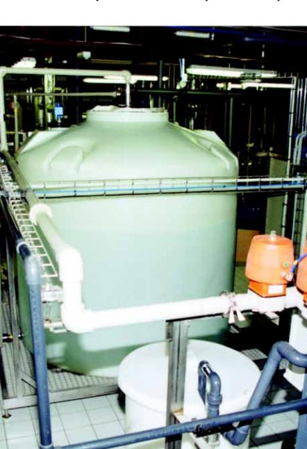
Перед тем, как перейти к квалификации функционирующего оборудования, была выполнена санобработка системы и калибровка приборов и датчиков, а также первичная регенерация всех специализированных фильтров системы.
