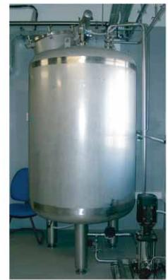
емкостях цилиндрической или эллипсоидной формы с исключительно гладкой поверхностью (менее 0,8 мкм), обеспечивающей отсутствие застойных зон.
